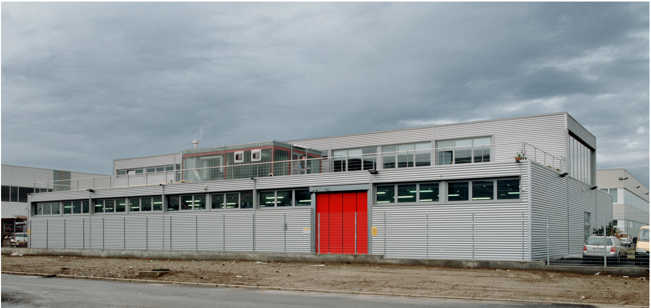
Figura 6 Stabilimento Omnes, Collegno (TO), PAT. architetti associati. Foto Tommaso Buzzi.
