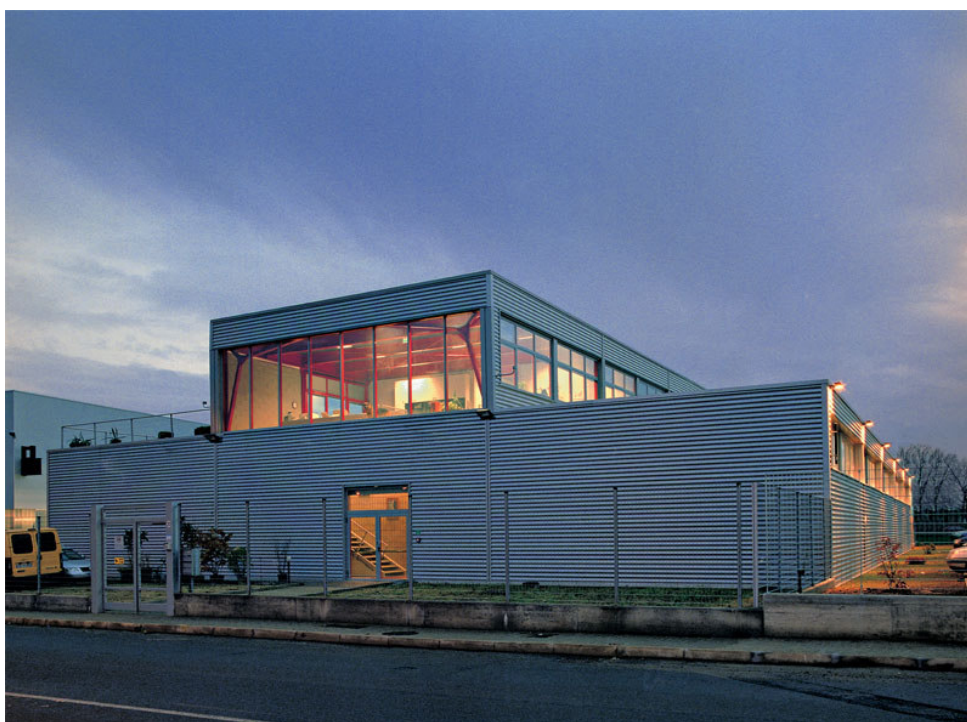
Figura 5 Stabilimento Omes, Collegno (TO), PAT. architetti associati. Foto Tommaso Buzzi.
